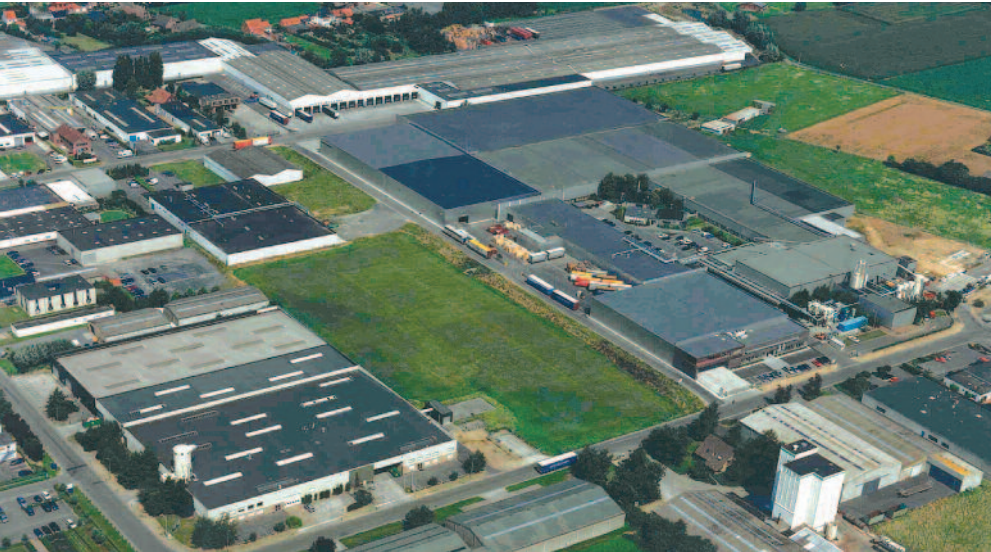
RECTICEL-Werk in Wevelgem/Belgien
