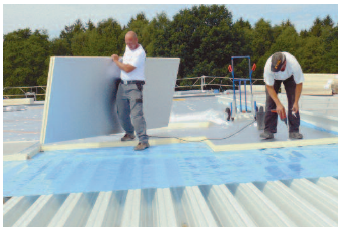
POWERDECK® auf Stahltrapezprofilen
